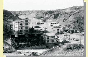
Bild 7: Die Khan-Mine, hier wurden eine Maschinenanlage mit Röhlantrieb, eine elektrische Zentrale mit 560 PS und eine Aufbereitung errichtet.
