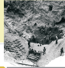
Bild 6: Anfangs wurde in Tsumeb das Kupfererz, und in der benachbarten Grube Abenab das Vanadium-Erz hauptsächlich im Tagebau gewonnen.
