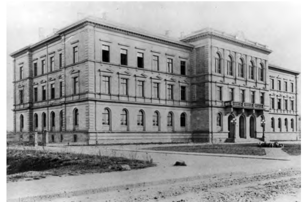
DAS NEUE HAUPTGEBÄUDE DER UNIVERSITÄT GIESSEN, DAS IM SELBEN JAHR ERRICHTET WURDE, IN DEM RÖNTGEN DORT SEINE STELLE ANTRAT
