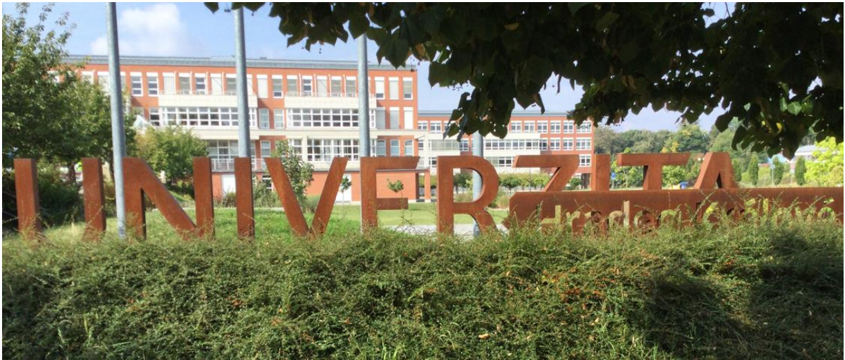
Abb. 4: Teilgebäude der Universität
