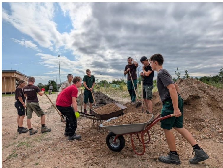
Abbildung 2: Wegebau mit der Unterstützung der Berufsschule Ochsenfurt im CampusGarten 2.0
