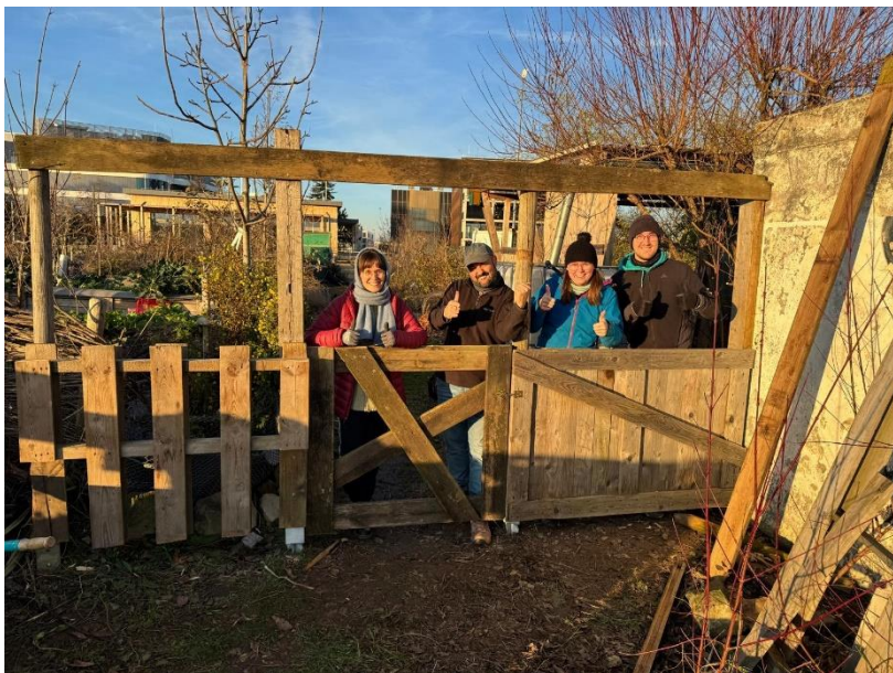
Abbildung 5: Bau von Toren an den Eingängen des CampusGarten 2.0
